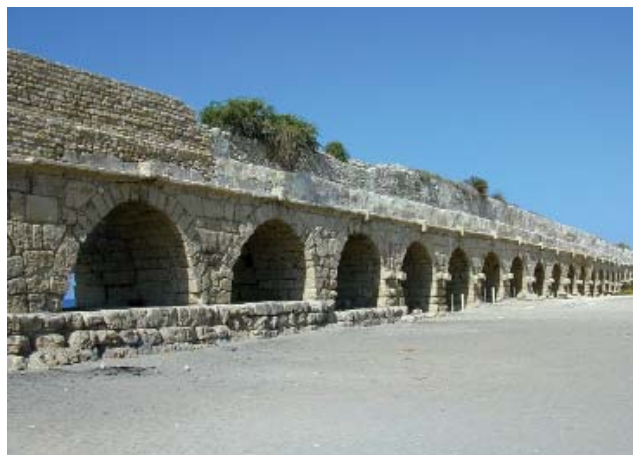
罗马在凯撒利亚建筑的引水桥
